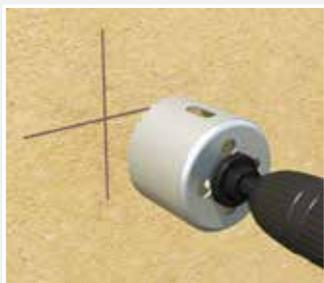
Création de l'ouverture de montage Ø 68 mm à l'aide d'une fraise appropriée (par exemple, n° art. 1083-70, lame de fraisage et l'éjecteur à platines doivent être démontés).
