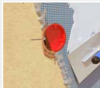
Avant de procéder au plâtrage, insérez le couvercle de signalisation (n° art. 1181-60). Il protège l'intérieur de la boîte, les dômes et les têtes de vis.
